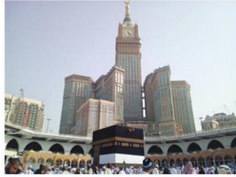
الشكل (١٢): المسجد الحرام.
